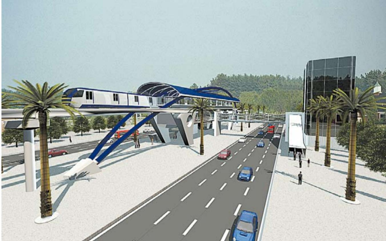
**Concepção do monorilho: novo sistema funciona com tração elétrica e corre sobre pneus numa via elevada (12 a 15 metros de altura)**
